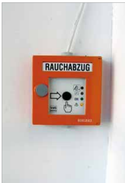
Tlačidlový hlásič EPS.
