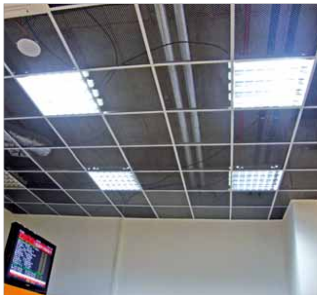
Perforácia podhládu v rozsahu viac ako 25 %.
